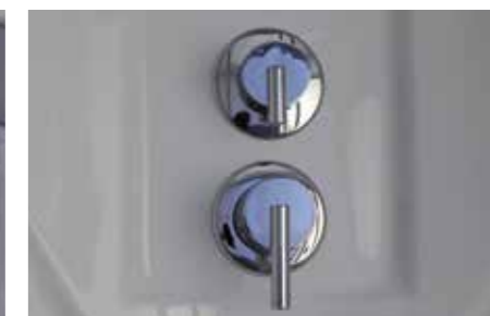
Miscelatore meccanico e deviatore a 4 vie Mechanical mixer and four-way diverter
