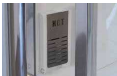
Diffusore vapore con contenitore sali Steam diffuser with salt container
