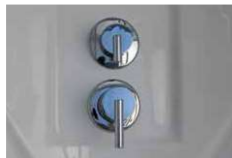
Miscelatore meccanico e deviatore a 4 vie Mechanical mixer and 4 way deviator
